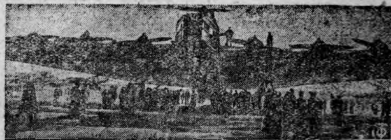
Величайший в мире Агитсамолет имени великого пролетарского писателя Максима горького закончен постройкой. Самолет конструкции инженера А. Н. Туполева, оборудован семью моторами, размах крыльев—65 метра, длина корпуса—35 метров. Колеса в диаметре в рост человека, 2-метра. На самолете будут помещаться: печатная типография, передающая радиостанция и т.д. Самолет предназначен для агитсамолетов по городам, рабочим районам и колхозам.
